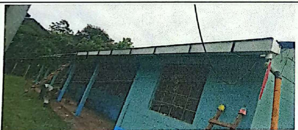
Foto 4: Cambio de canales y bajadas de agua pluvial
