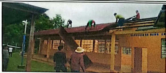
Foto1: Desmontaje del entechado de la escuela.
