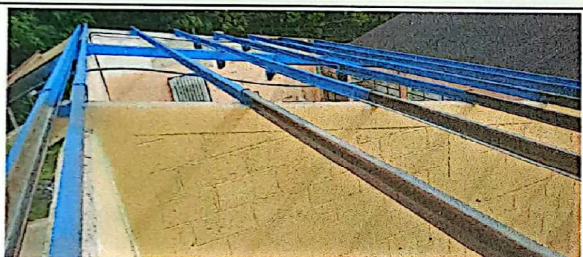
Foto 3: Pintura de costaneras.
