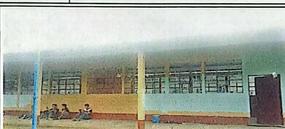
Foto 2: Trabajo de pintura del exterior de la escuela
