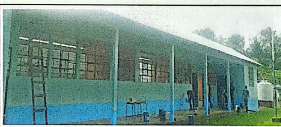
Foto 4: Pintura de interior y exterior.
